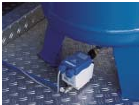
Bekomat 21 vedenpoistin asennettuna painesäiliön pohjaan
