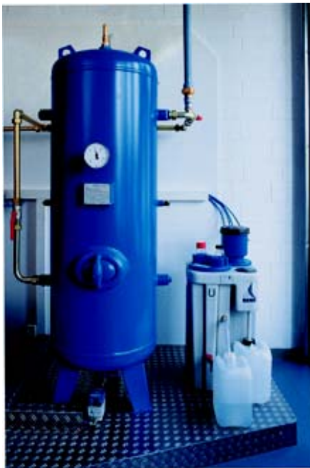
Bekomat vedenpoisto ja Öwamat kondenssiveden öljynerotus
