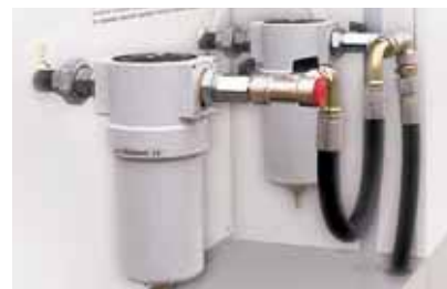
Paineilmasuodattimet ohituksella
